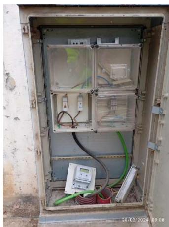
Foto 3 Interior armari existent
