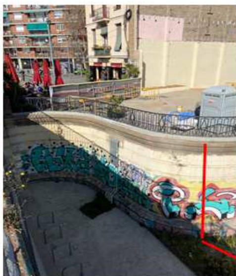
Definir fotografies: Anclatge al mur
