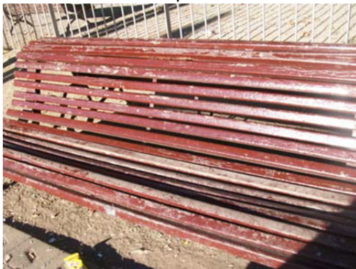
Foto 26: Banc amb pintura deteriorada
