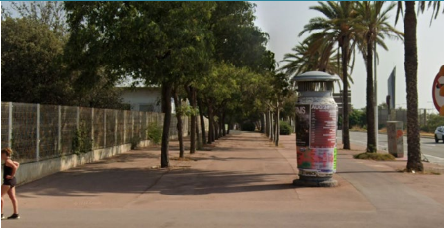
Zona pavimentada (las raíces de las tipuanas están levantando el asfalto)
