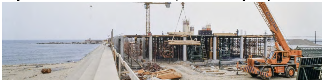
Imatge 6: Construcció de l'estructura de locals a cota port del moll del Gregal. Juny 1990
