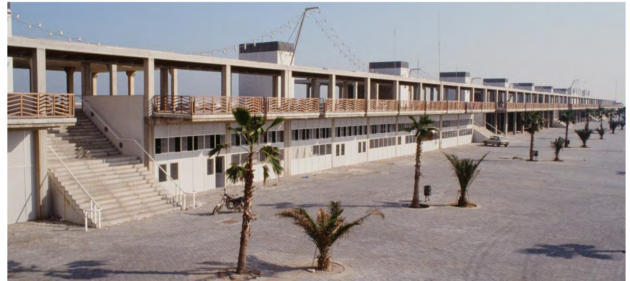
Imatge 11: Façana a port durant les obres del port. Febrer 1992
