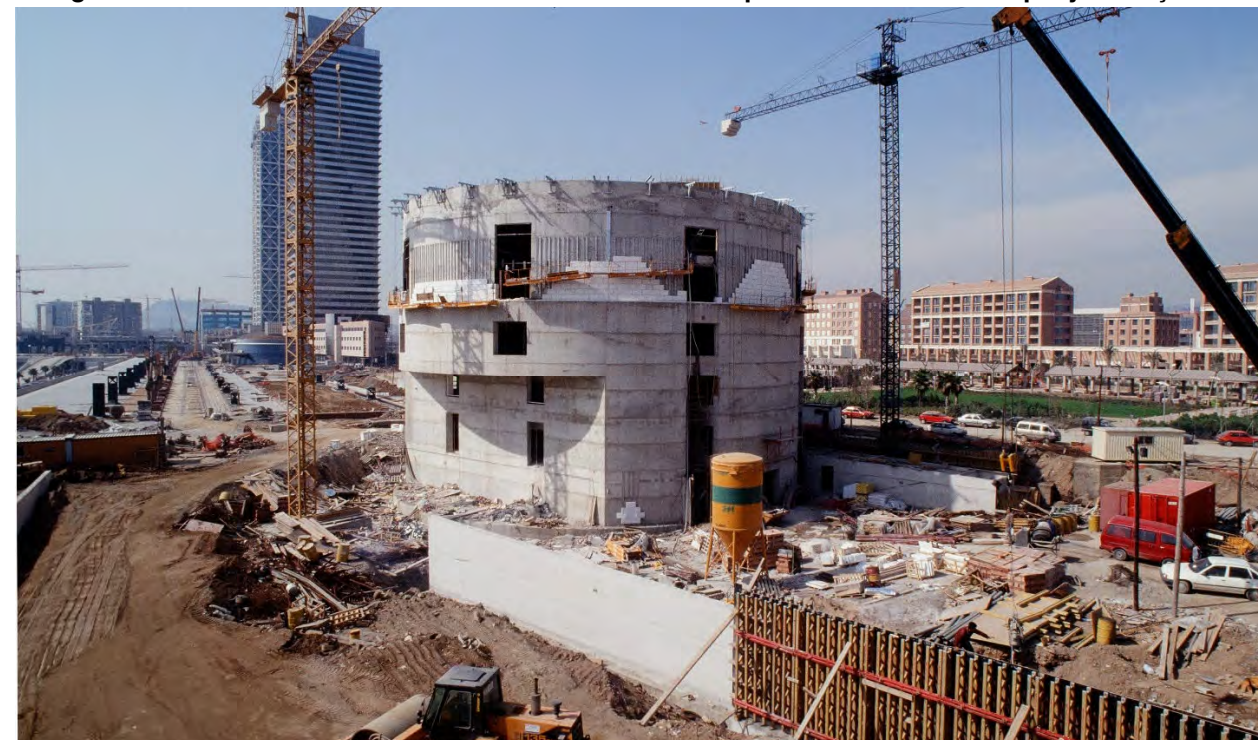
Imatge 19: Obres de farciments i murs a la zona de la rampa actual d'accés a la platja. Març 1992
