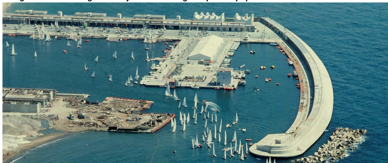
Imatge 34: Locals Gregal en les jornades de regates preolímpiques. juliol 1991
