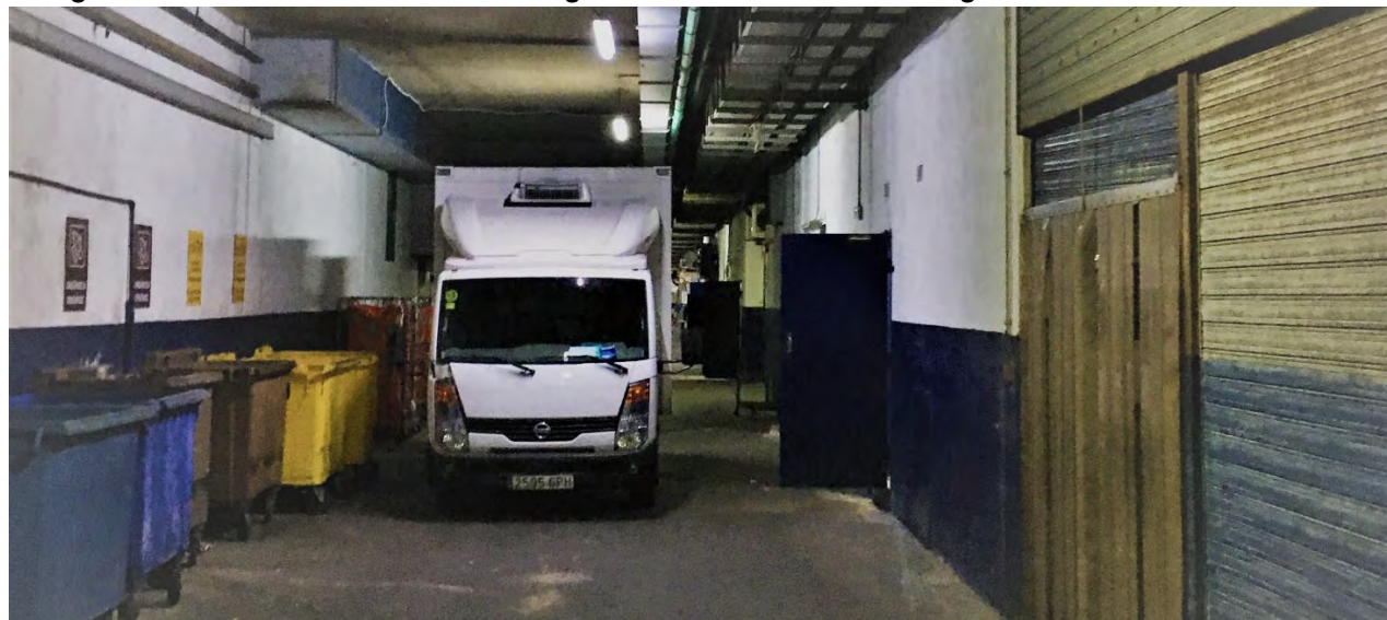
Imatge 13: Galeria de Serveis actual. Magatzems a la dreta de la imatge.
