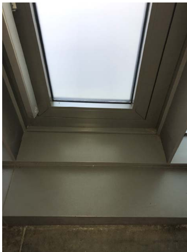
Fotos 8 i 9: Vistes detall de l'interior dels mòduls tipus de vidre fixe i d'exutori.
