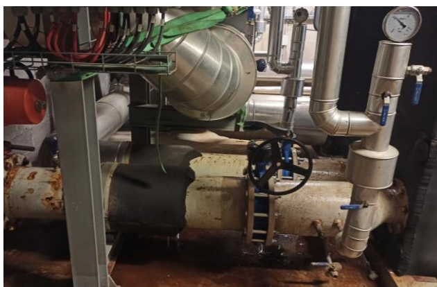
Substitució de claus circuit de fred i aïllament posterior.
