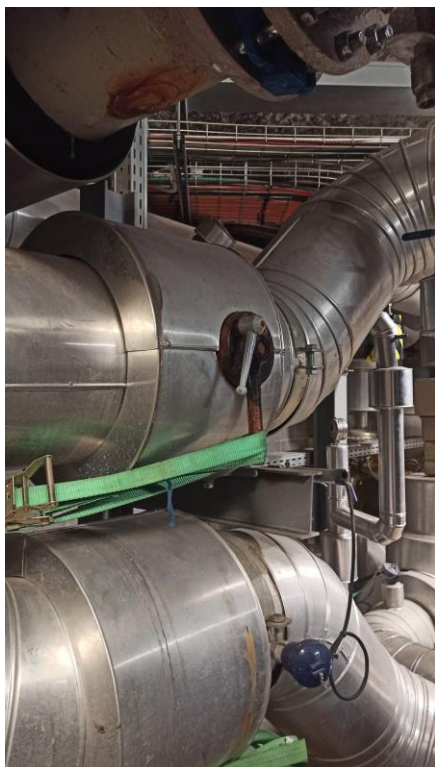
Substitució de claus circuit de fred i aïllament posterior.
