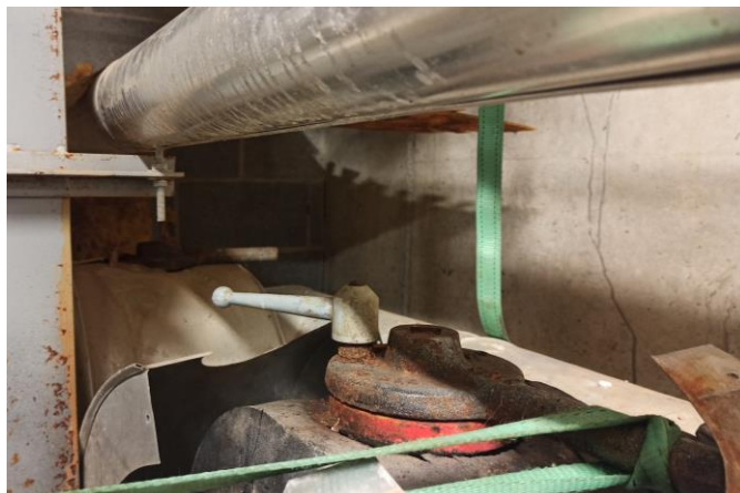
Substitució de claus circuit de fred i aïllament posterior.
