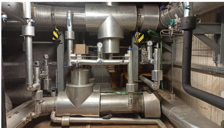
Circuit de fred. Desmuntatge de protecció d'alumini i aïllament existent per a la substitució de les vàlvules.
