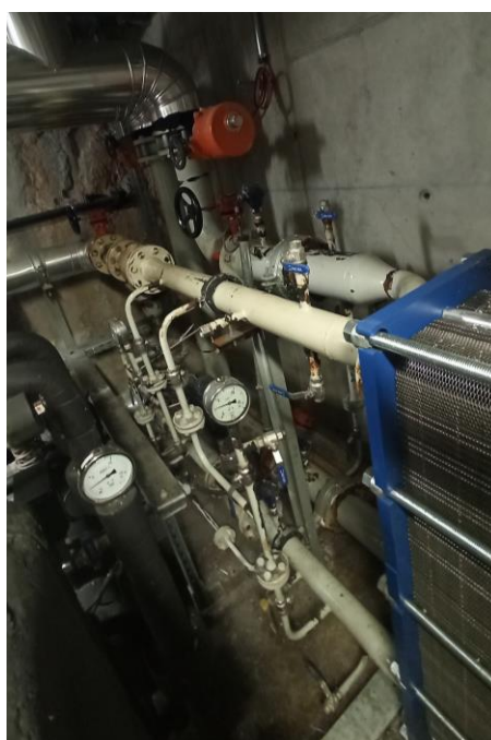
Tubs, vàlvules i accessoris circuit bescanviador calor
