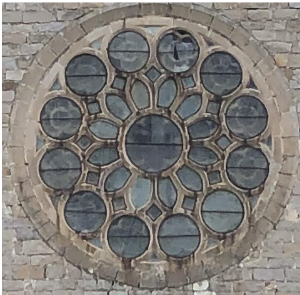
Figura 5. Vegis el sistema de Proteccions dobles fetes a base de malla metàl·lica en marc de ferro, damunt de vidre de protecció.
