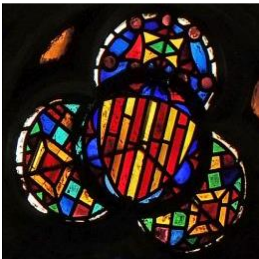
Figura 6. Els verguerons constitueixen una protecció del vitrall i son solidaris a aquest. Aquesta imatge, feta des de l'interior, permet apreciar-los.
