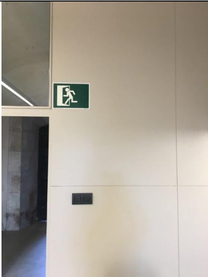
Foto cancell d'entrada. Sala 31 Aula taller. Detall panells tancament opac d'acer
