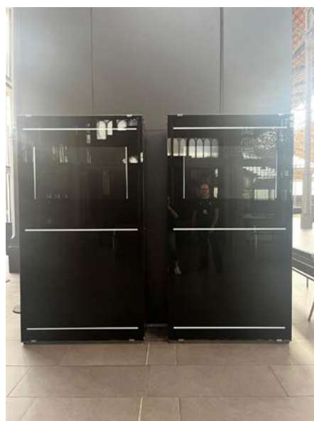
Desmuntatge i gestió de residus de 5 tòtems amb estructura metàl·lica, revestiment de vidre laminat i monitor interior, de mides totals 120x40x220 cm
