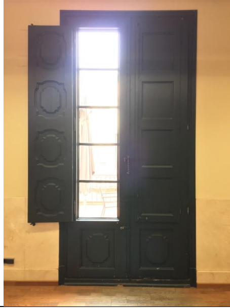
Balconera tipus B, a façana pati principal costat portal pageses. Vista interior.
