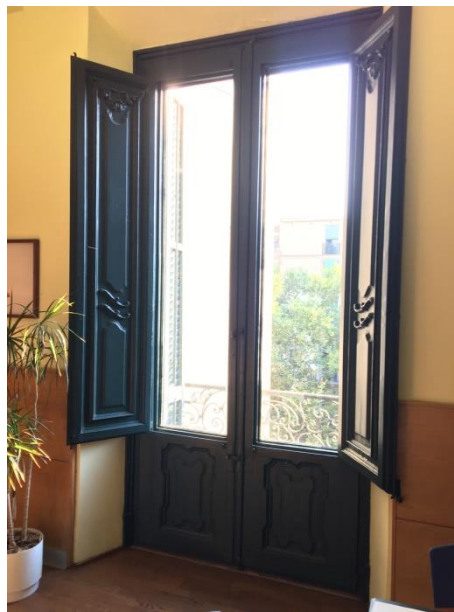
Balconera tipus A, a façana principal. Vista interior
