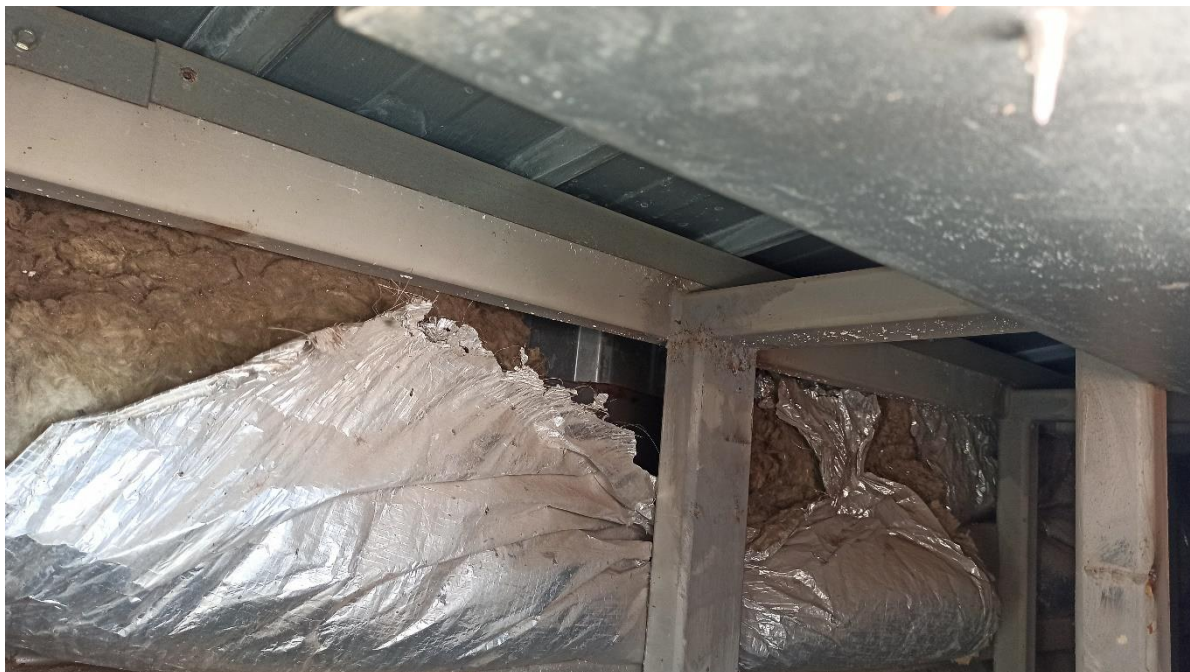
Estructura metàl·lica d'ancoratge de l'estructura de suportació del vidre.
