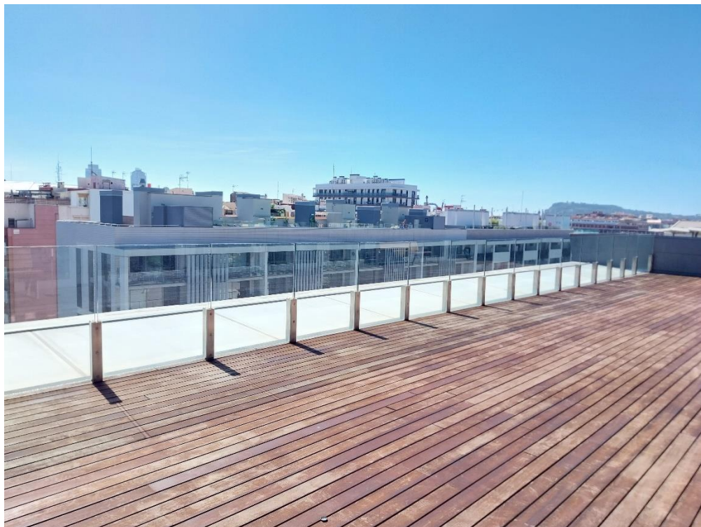
Terrassa. Barana frontal de vidre.
