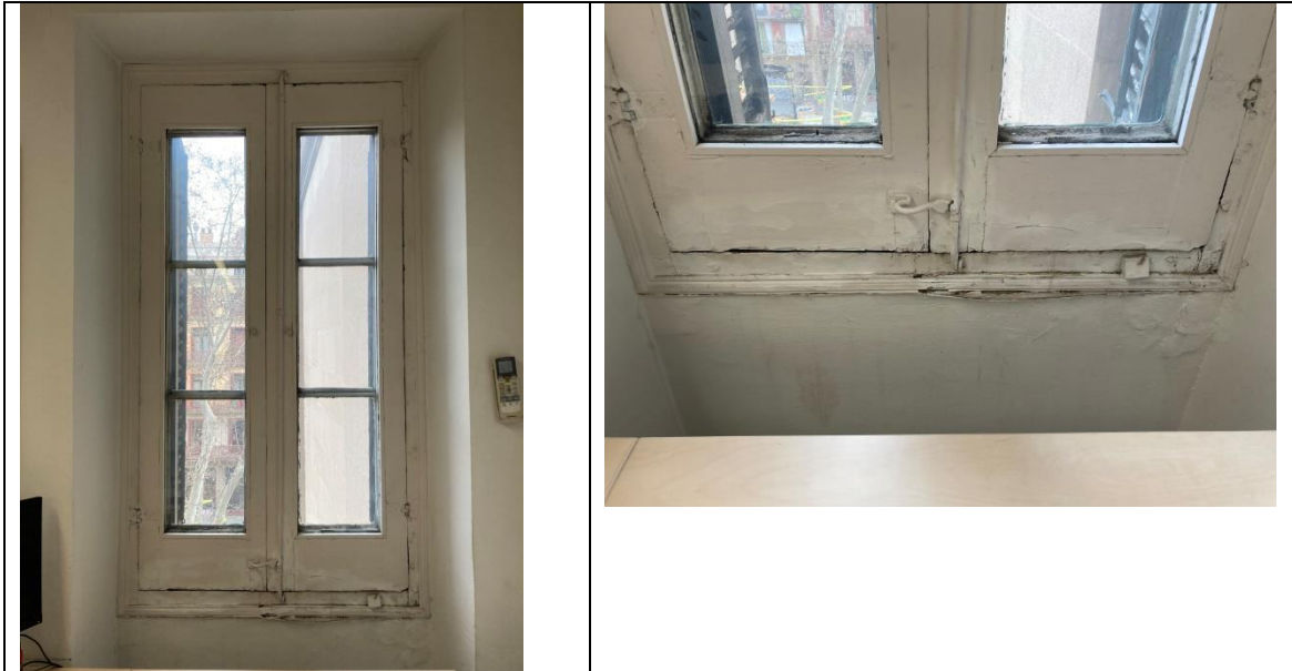
Finestra B3, tercera planta
