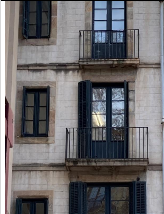
Balconera A 2 i finestra B 2 . Segona planta. Façana principal. Vista exterior
