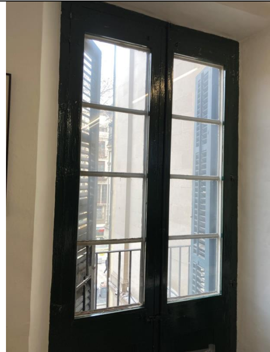
Balconera A 2 . Segona planta. Vista interior
