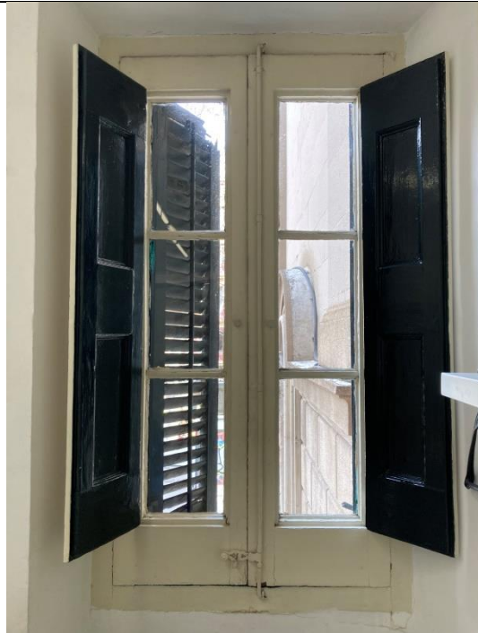
Finestra B1. Primera planta. Vista interior
