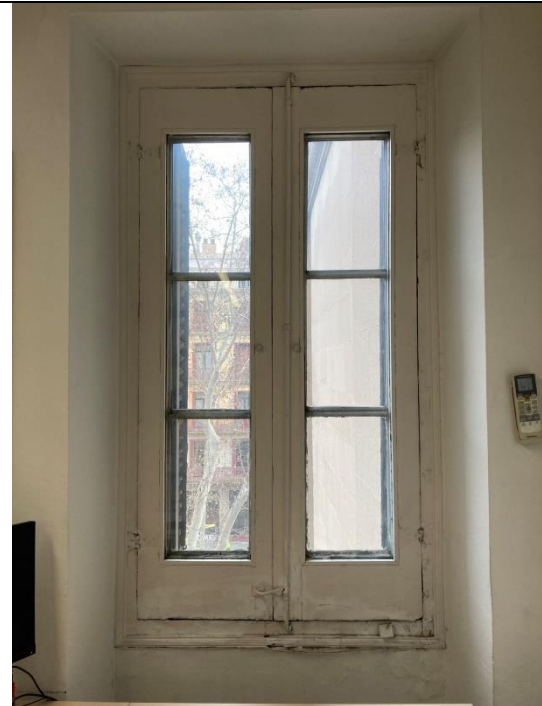
Balconera A 4 . Tercera i quarta planta. Vista interior
