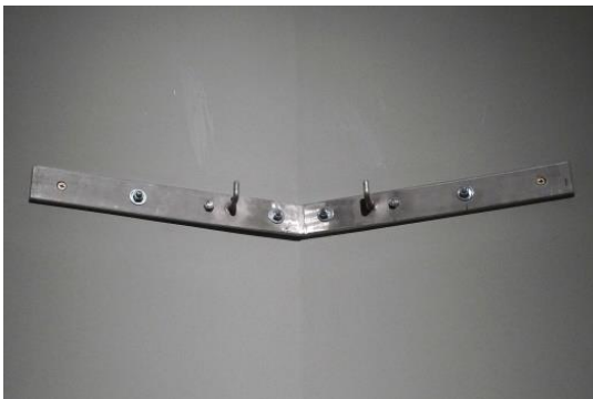
Detall dels suports de subjecció a paret amb angle. Detalls part superior i inferior.
