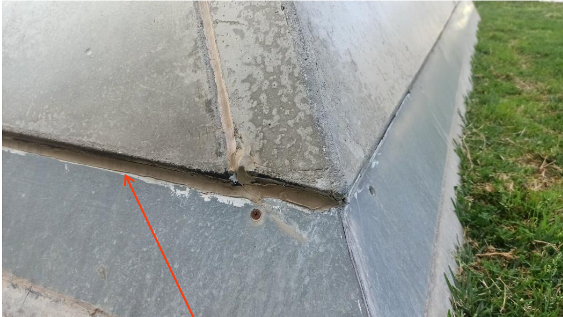
Junta inferior horitzontal fora de l'àmbit d'intervenció
