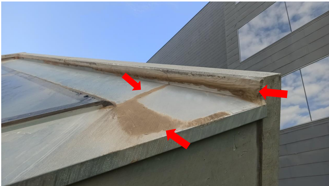
Inclou juntes entre elements metàl·lics
