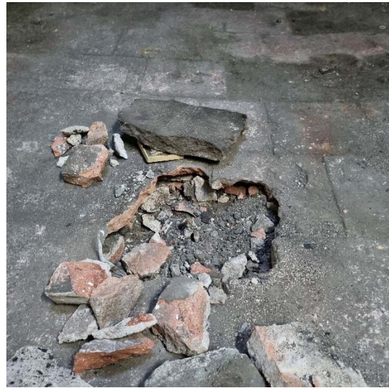
Cata en el paviment
