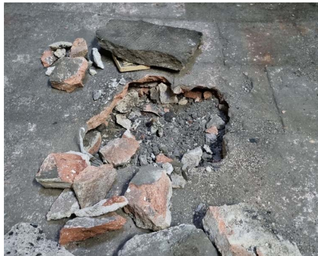
Cata en el paviment de planta baixa
