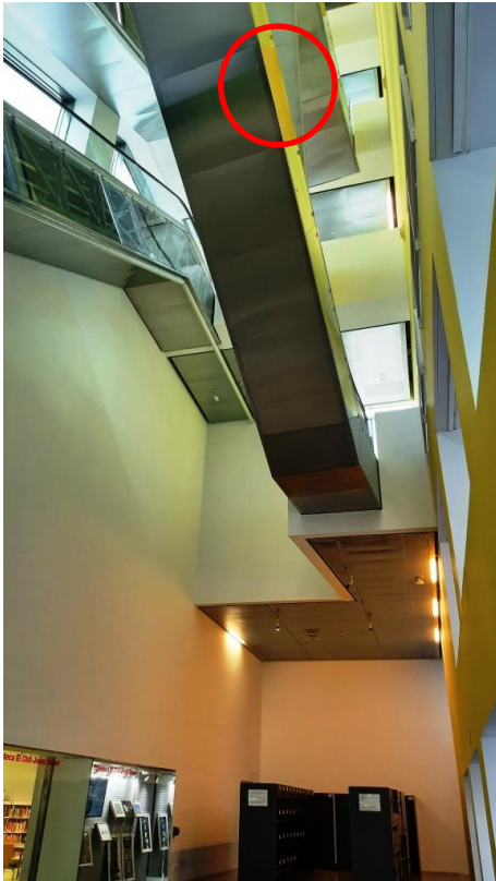
Vista des de la planta B, cota +6.98.
