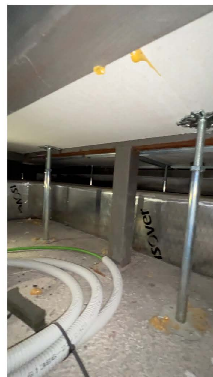
El conducte de climatització que cal desviar, i també s'aprecien els muntants verticals estructurals que suporten la perfil·leria de la façana de vidre.
