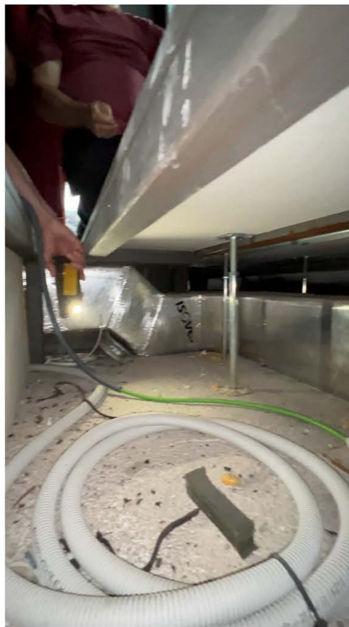
Veiem com podem desviar una part del conducte de climatització per tal no quedi la reixeta d'impulsió a la part que ara quedarà a l'exterior.
