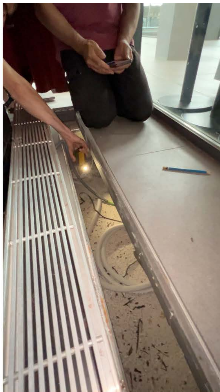
Per poder recolzar l'estructura de muntants verticals del nou pòrtic d'entrada, s'han inspeccionat els baixos del terra tècnic a través de les parts registrables i dels conductes de climatització.
