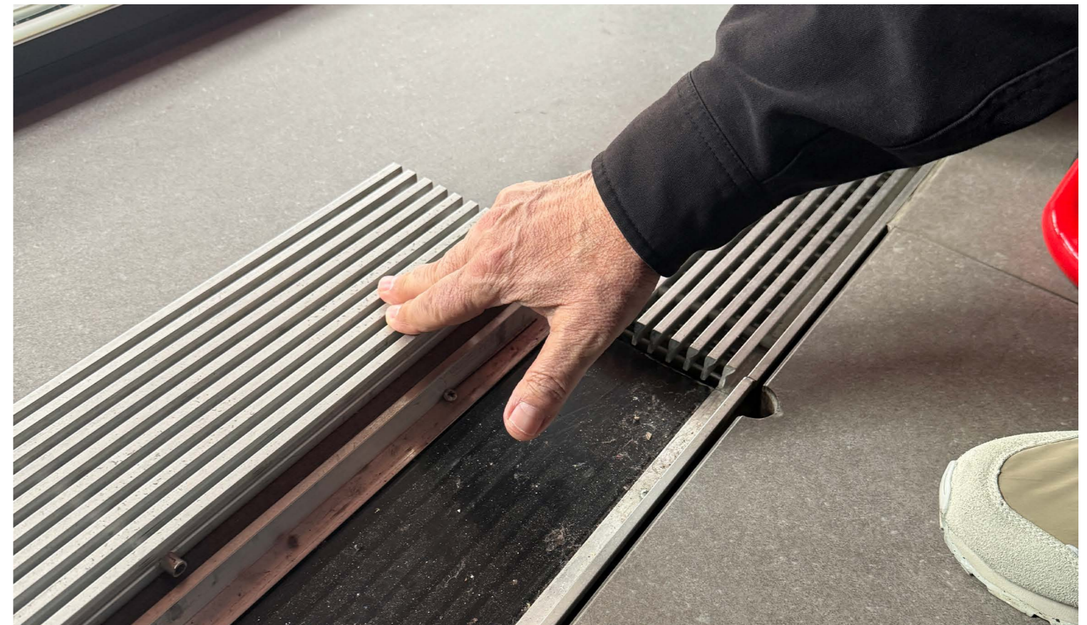
Reixes de ventilació a intervenir
