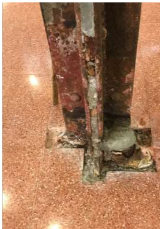
Detall dels perfils metàl·lics que conformen els pilars
