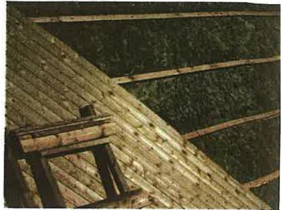
Foto 25 – Lana mineral en la cubierta
