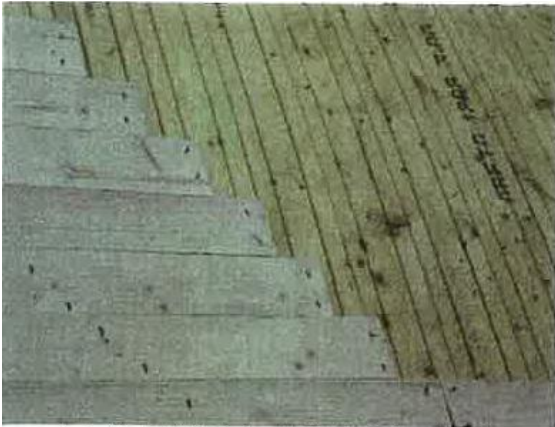
Foto 24 – Detalle del entablillado de la cubierta
