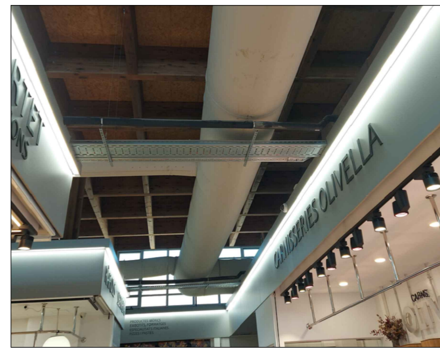
Vista inferior col·lector general
