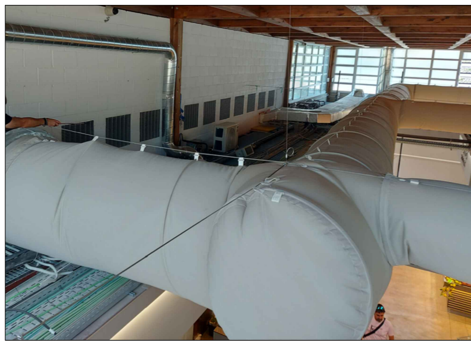
Col·lector general a mantenir i col·locar peça especial per baixar els 3 ramals
