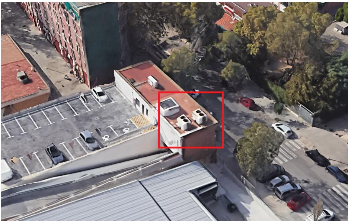
Unitats exteriors de climatització tipus bomba de calor ubicades en coberta
