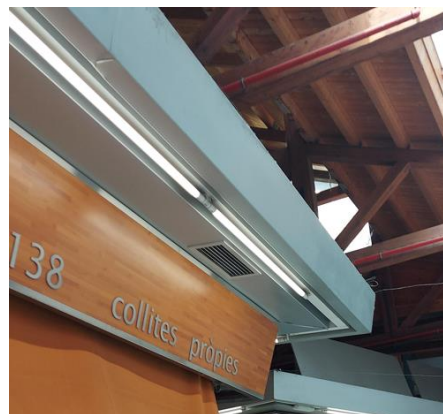
Cornisa perimetral de les illes que es manté amb reixes clima e il·luminació del mercat.
