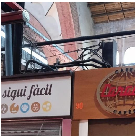
Pilar amb tirants de suport sostre parada.
