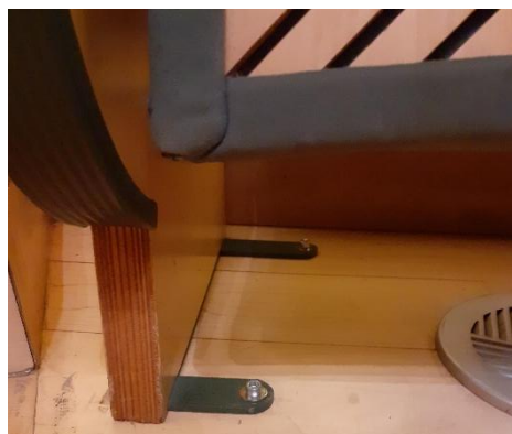
Platina de fixació a terra butaca Sala 1
