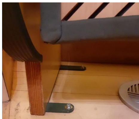
Platina de fixació a terra butaca Sala 1
