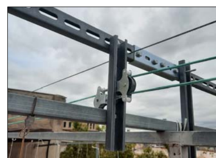
SISTEMA ACCIONAMENT TENDALL CORRIOLES
